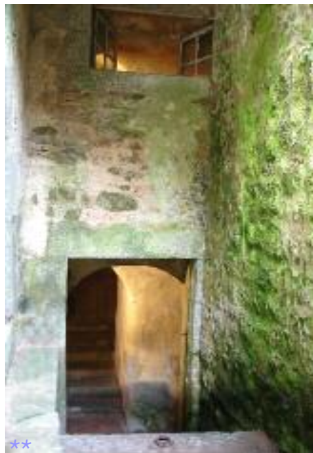
** Accès aux caves. La fenêtre est au niveau des entresols.
